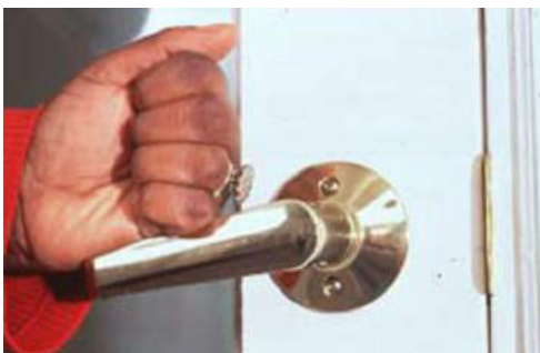
Fot. 6. Klasyczna klamka-dźwignia, która wymaga użycia mniej wysiłku niż klamka-gałka (raport The Principles of Universal Design )
